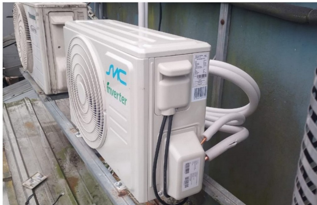
INSTALACIÓN DE CLIMATIZACIÓN
