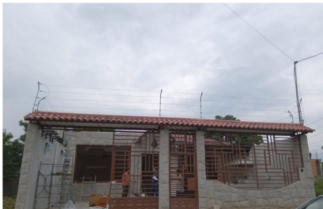
INSTALACIÓN DE CERCO ELÉCTRICO
