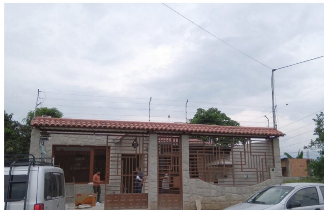
PROTECCIÓN PERIMETRAL INTEGRAL
