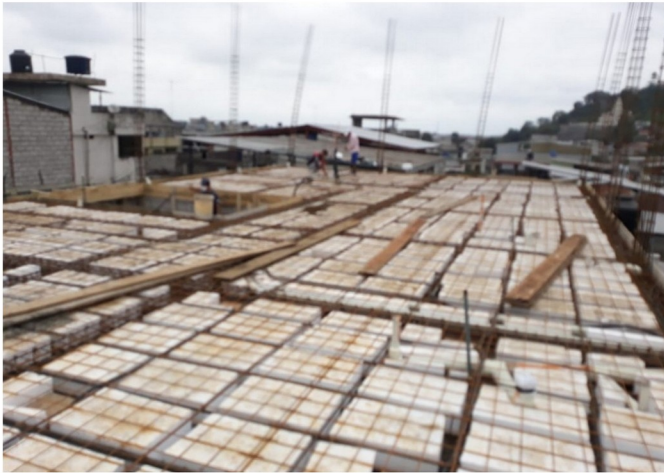
INSTALACIÓN EMPOTRADA DESDE OBRA CIVIL
