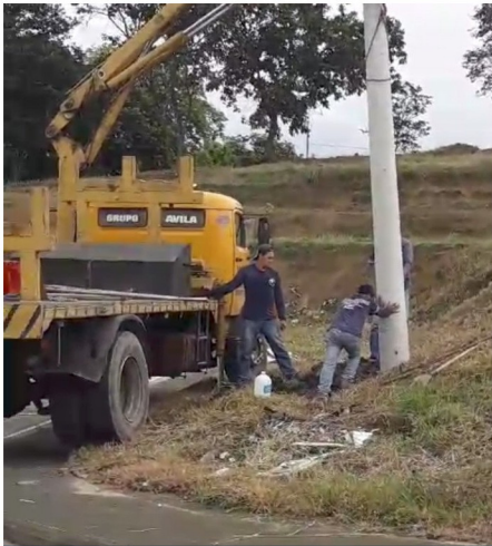
MONTAJE DE POSTES
